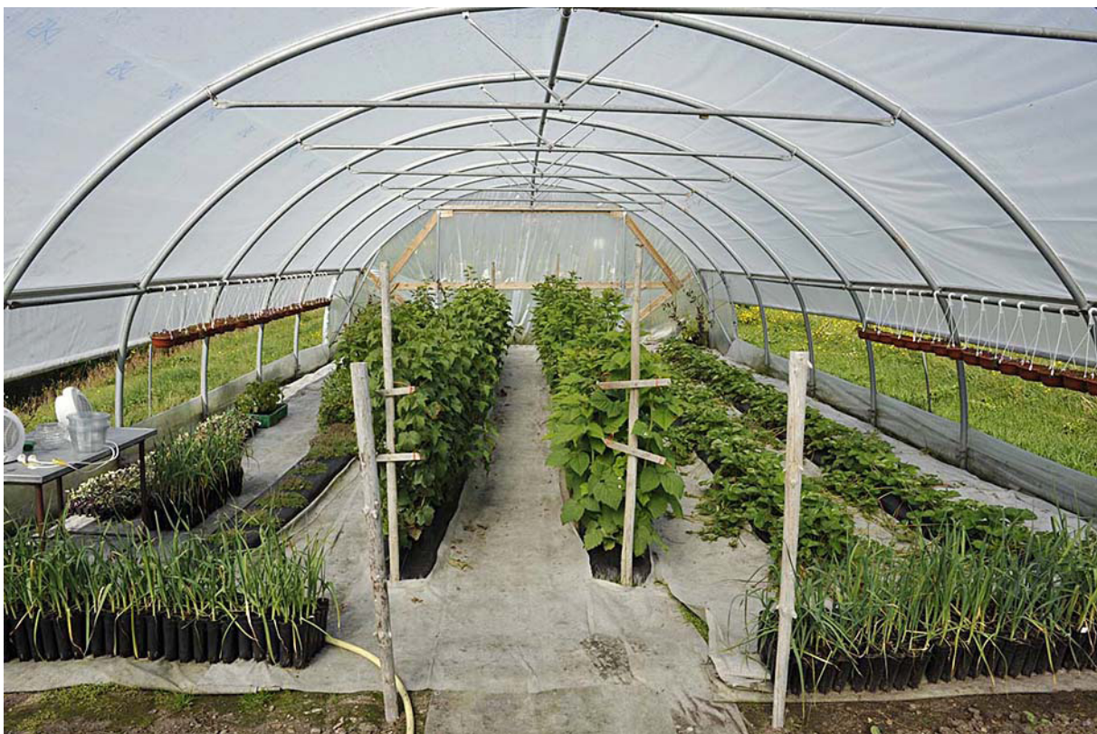
Tunnelformet drivhus på Upernaviarsuk. Drivhuse i Grønland skal kunne modstå kraftige stormvejr. (Foto: Uffe Wilken).
